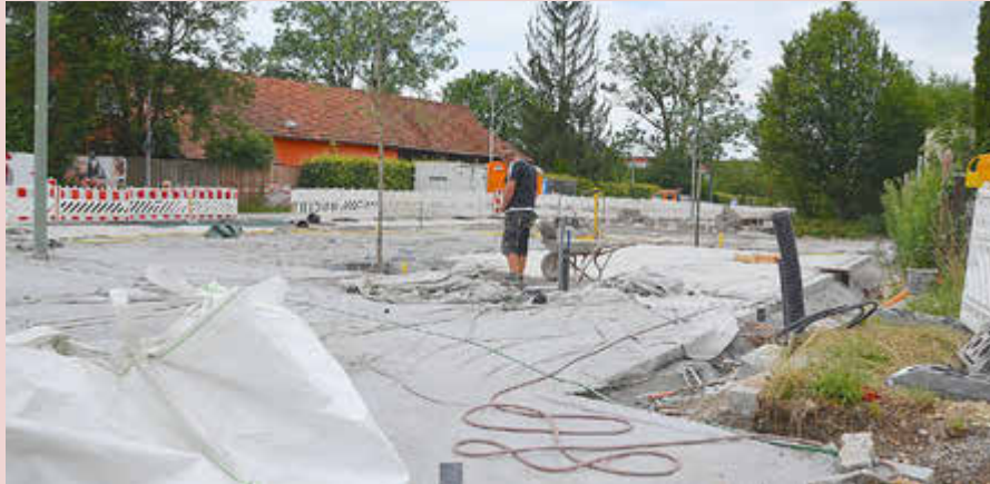
Letzte Arbeiten an der Einfahrt zur Haltestelle „Königsbrunn Zentrum“. Rechts im Bild ist der Anschluss für einen Trinkbrunnen zu sehen.
