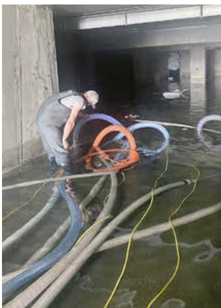
Wieder vollgelaufene Tiefgaragen und Keller ... Foto: Feuerwehr Königsbrunn
