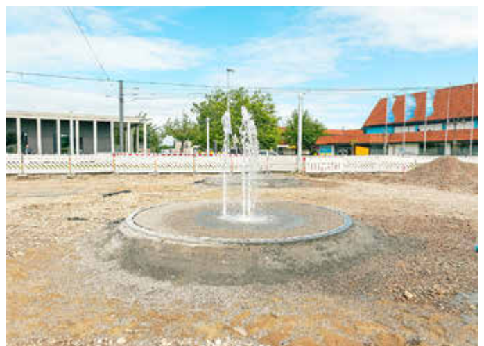
Der erste Pumpentest
