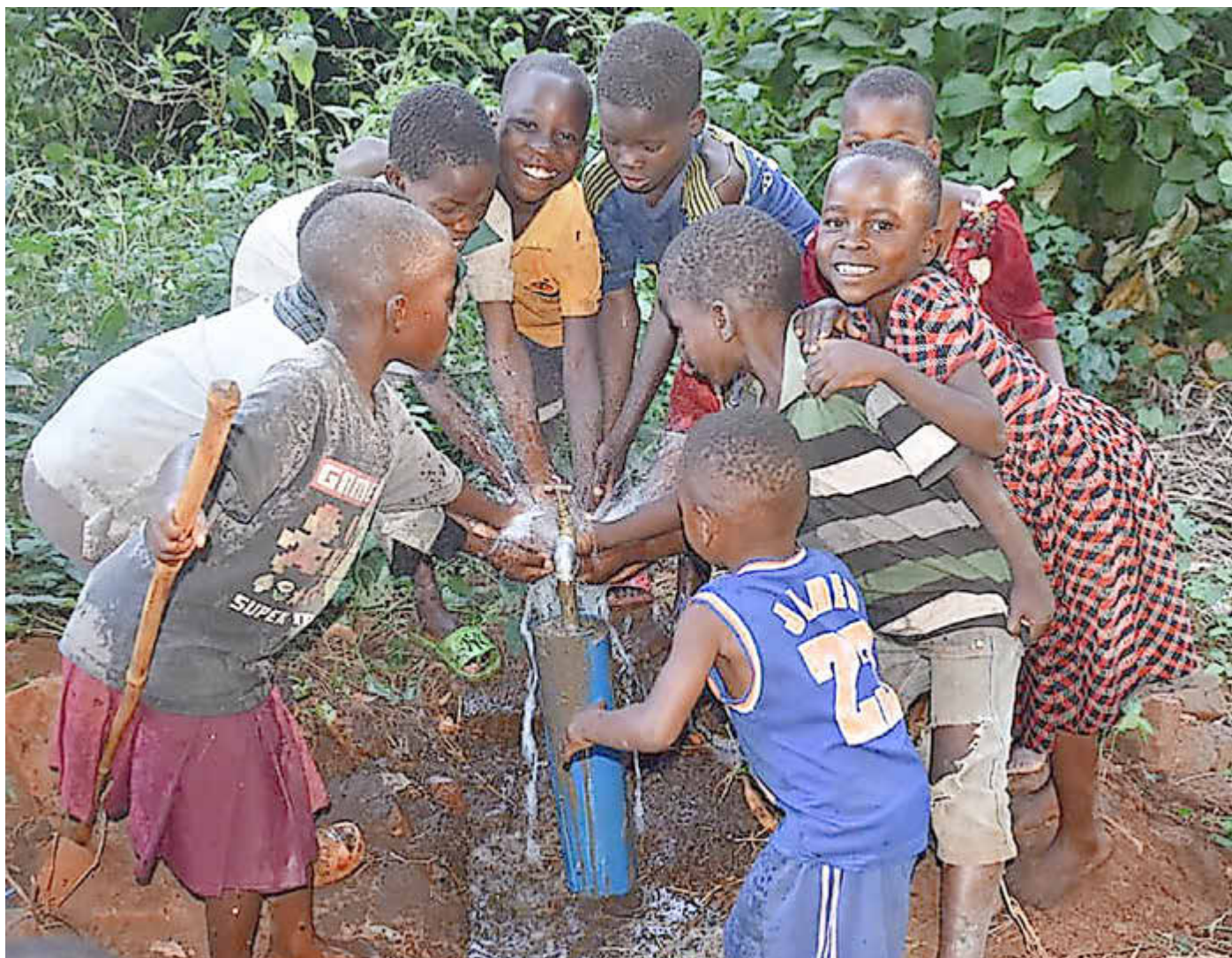
Eine fertige Wasserentnahmestelle im Dorf WOYO, Tansania
