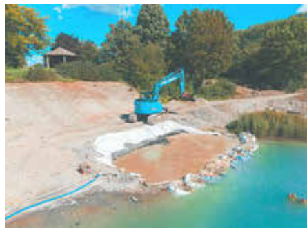
Baggerarbeiten im Bereich der geplanten Aussichtsterrasse
