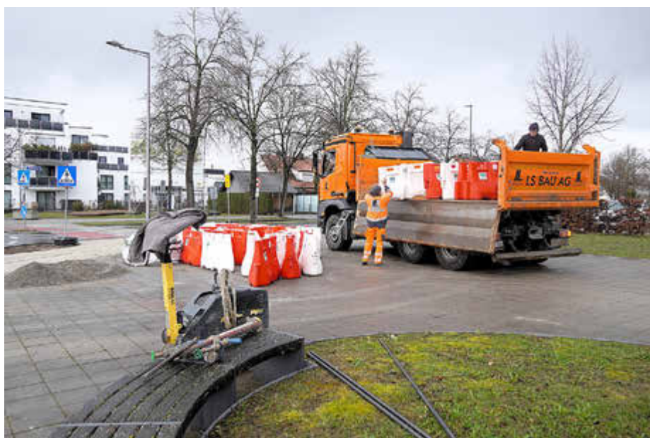
... wurden die Absperrungen abtransportiert.
