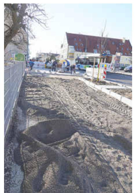
Im östlichen Gehwegbereich – kurz vor St. Ulrich – liefen bei Redaktionsschluss noch Pflasterarbeiten.
