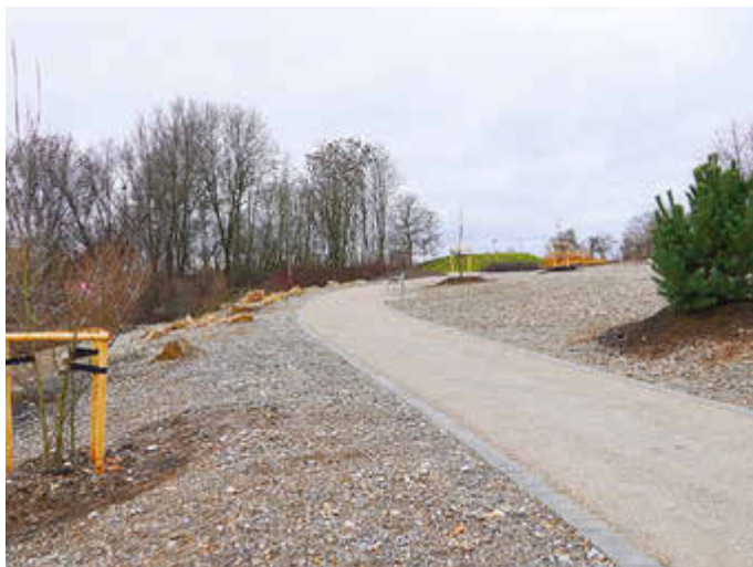
Auch die Wegbauarbeiten konnten im Dezember 2025 erfolgreich abgeschlossen werden.
