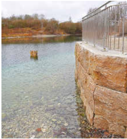
Die Aussichtsplattform wurde aus massiven Natursteinblöcken in Form eines Achtecks erbaut.
