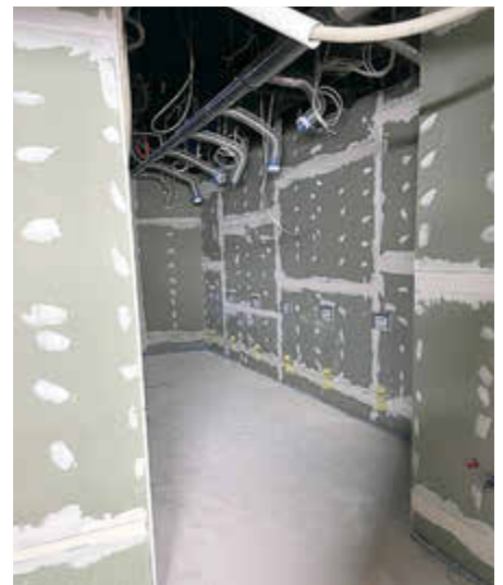
Ein Blick in den neuen Toiletten-Kern, bevor die Fliesen angebracht werden.
