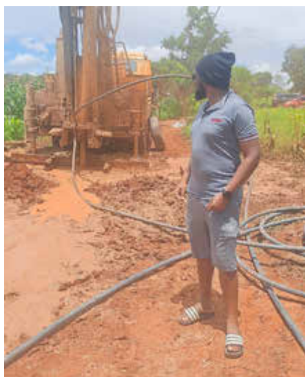
... und der Bohrvorgang für den neuen Brunnen
